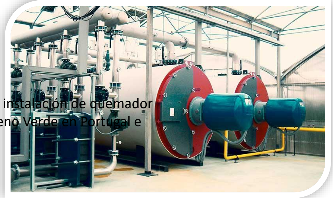
Boiler 10 tn/h, mezcla: Light oil-H2V, Planta Petroquímica, Indonesia
